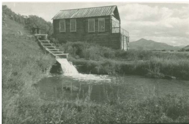
Фото 3. Сельская гидроэлектростанция сельхозартели «Путь Ильича». Посёлок Чёрный Ануй Усть-Канского аймака. 31.08.1951 г. Фотография Н. Немнонова.
